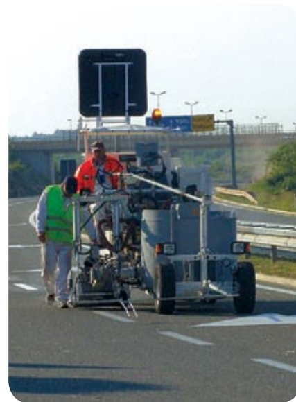
Obnova horizontalne signalizacije
