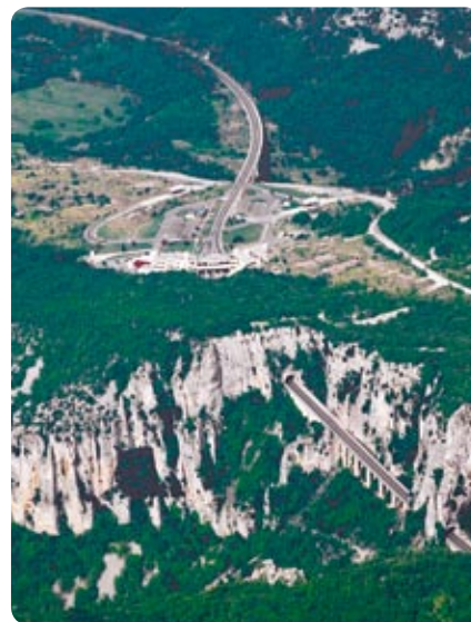
Tunel Učka - portal Istra s upravnom zgradom
