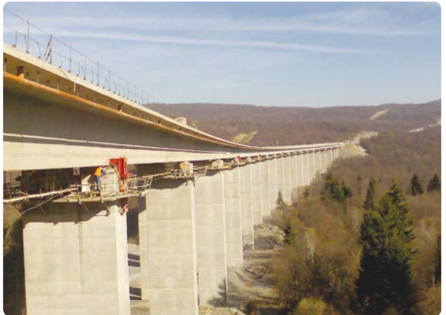
Autocesta Rijeka-Zagreb, vijadukt Zečeve drage
