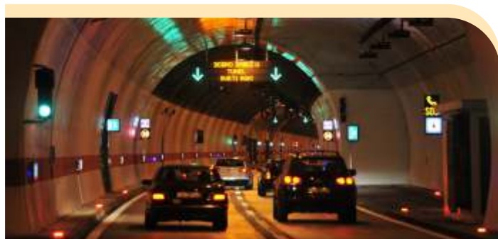
Unutrašnjost tunela Sveti Rok
